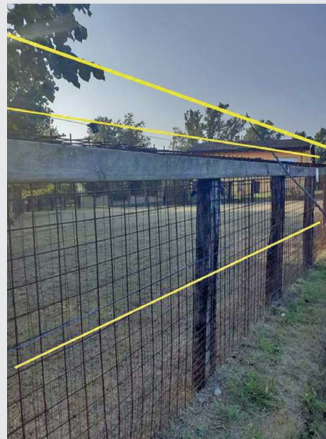
Recinzione mista fissa.
