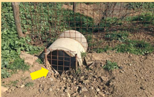
Il tubo di scolo va protetto con la rete elettrosaldata.
